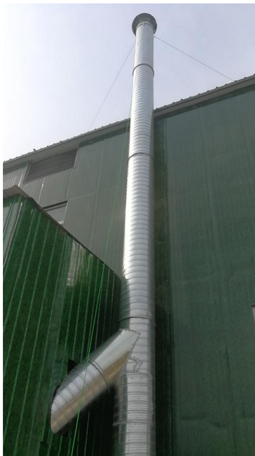
18m 高排气筒
