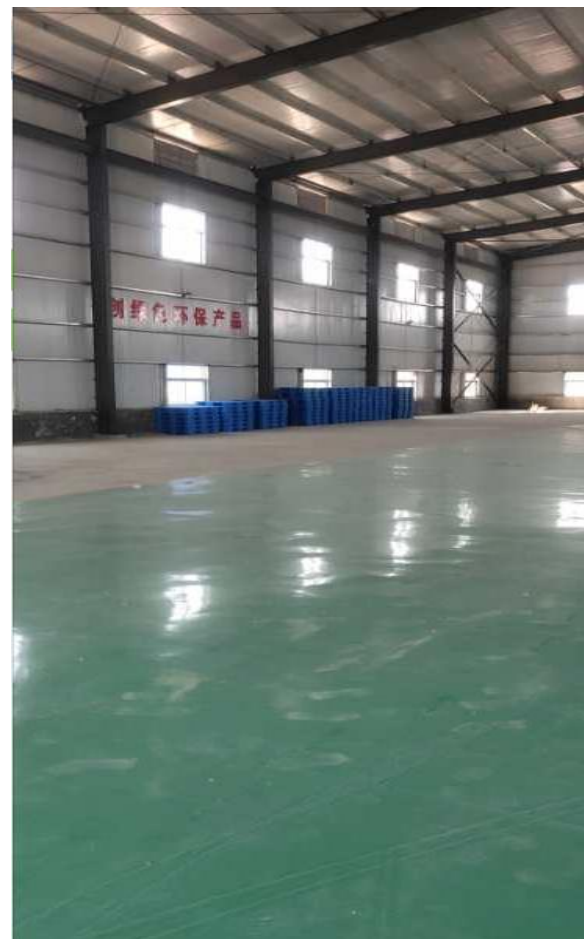
车间地面防渗
