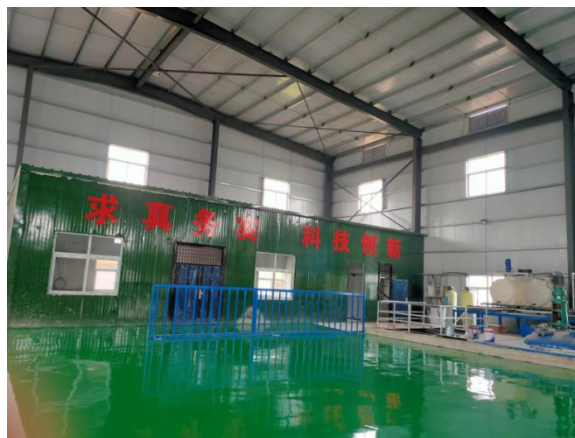
车间地面防渗层
